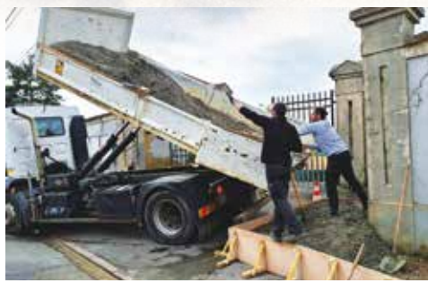
Réalisation d'une rampe PMR
