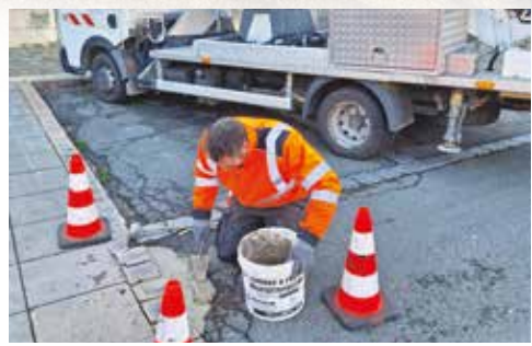
Réparations de voirie
