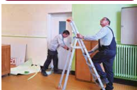
Réfection des peintures à l'école Chat Perché
