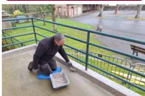
Étanchéité du toit terrasse : cantine
