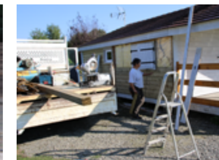
Réfection des Chalets
